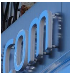
Eclairage en arrière des lettres, visible en se réfléchissant sur le fond
