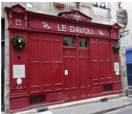
Enseigne en lettres découpées Inscriptions symétriques sur piédroits
